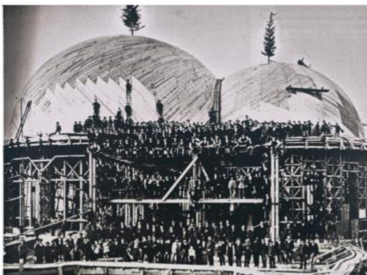
1 er avril 1914 : La Fête du Faîte (ou de la charpente) On met un sapin (ici deux) au(x) sommet(s) de la charpente terminée.
